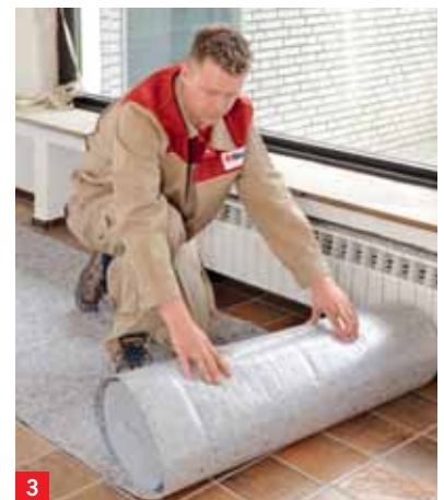
3 Sorgfältiges Abdecken aller Montagestellen und Laufwege ist selbstverständlich
