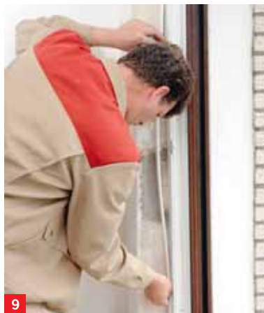
Abdeckung und Verleistung der inneren Anschlussfugen
