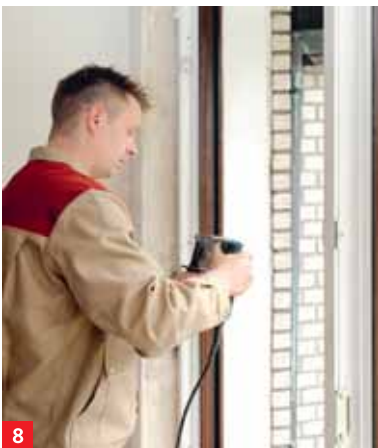
Saubere, präzise Befestigung des Fensterrahmens
