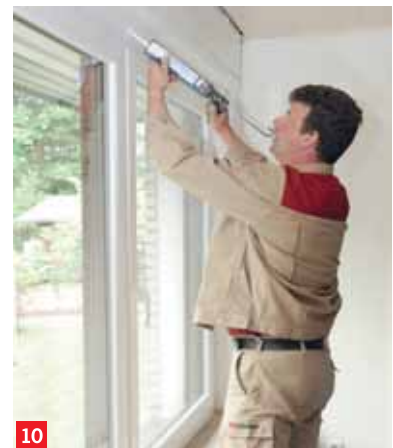
Winddichte Versiegelung von innen und außen erfolgt zum Schluss der Montage
