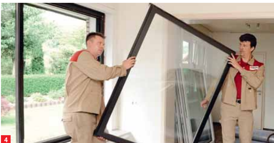
4 Herausnahme des alten Fensterflügels
