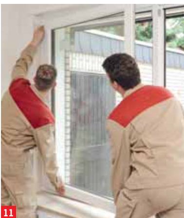
Einhängen des neuen Fensterflügels
