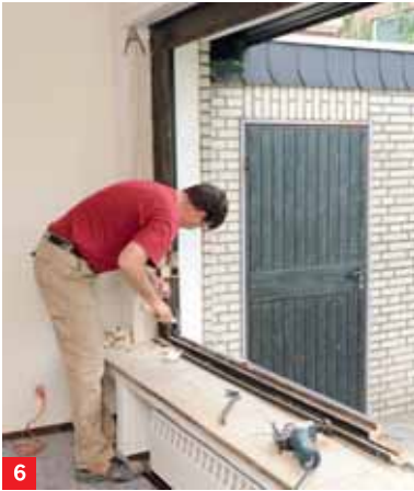
Ausbau des alten Fensterrahmens
