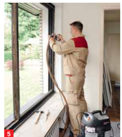
5 Demontage des alten Fensterrahmens – modernstes Schneidegerät mit Absaugung verhindert jede Beschädigung an Putz und Tapete
