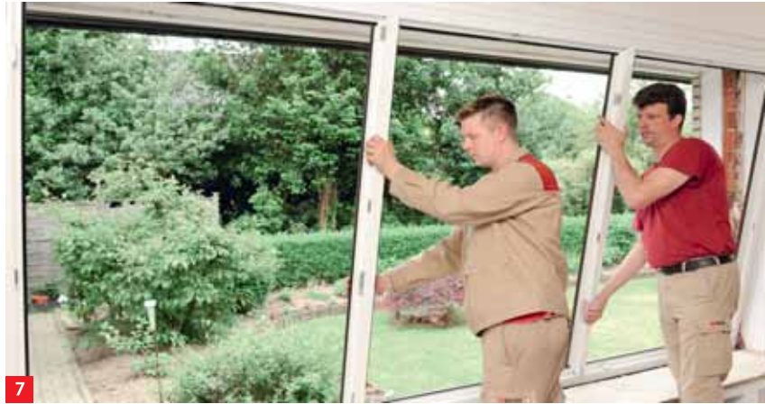
Einsetzen und Ausrichten des neuen Fensterrahmens
